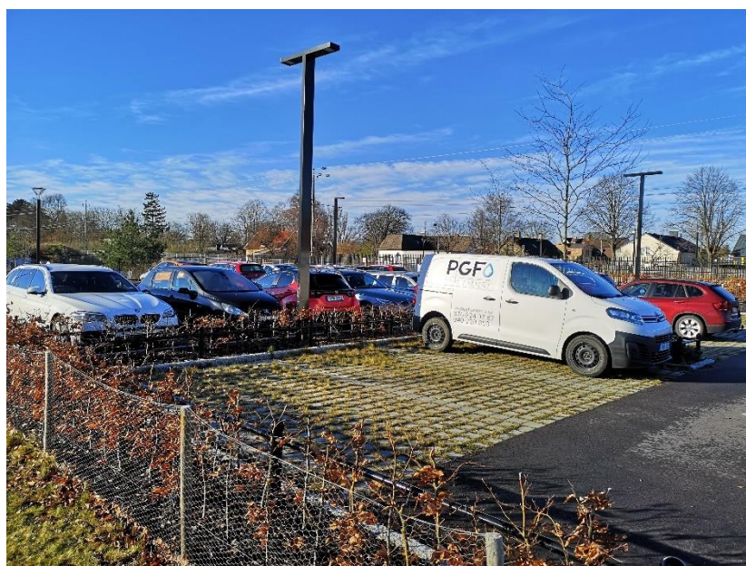
Figur 33: Genomsläpplig beläggning på Lomma station.
