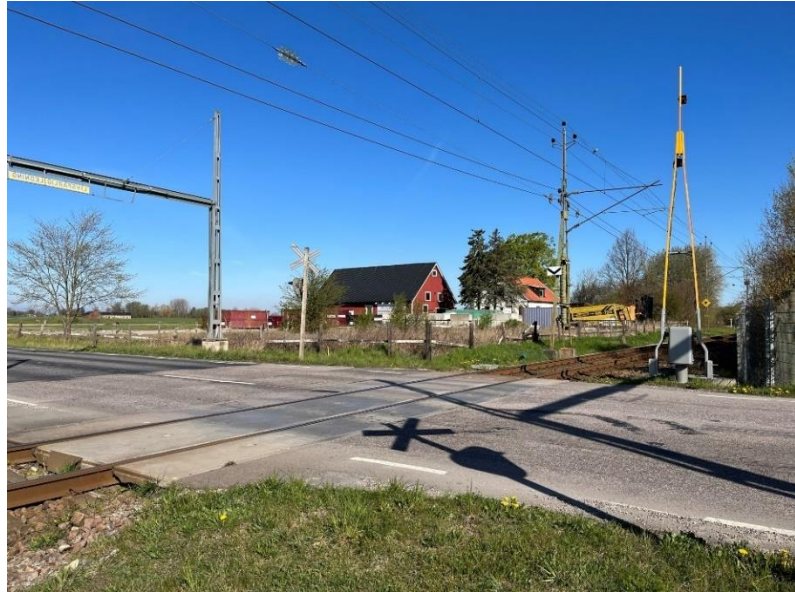
Figur 3: Bild på platsen där Lommabanan korsar väg 913 idag. För att öka trafiksäkerheten bygger Trafikverket om den befintliga plankorsningen om till en planskild korsning likt den som byggdes intill Lomma station på Vinstorpsvägen.
