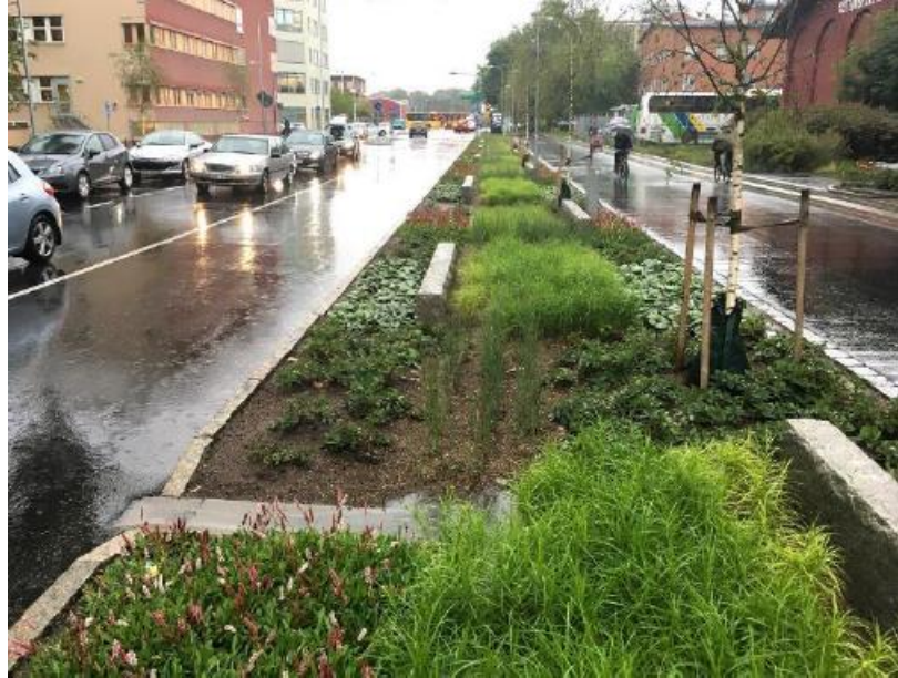
Figur 44: Exempel på nedsänkt växtbädd som omhändertar dagvatten som avrinner från väg och GC-väg. Foto: WRS, 2022
