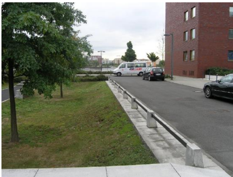
Figur 22: Exempel på en torrdamm i anslutning till en väg. Foto: WRS, 2022
