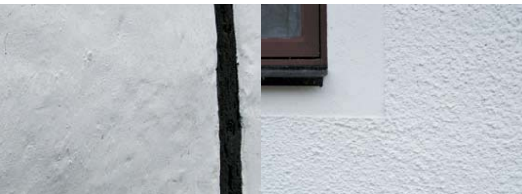
Den äldre bebyggelsen hade ofta en slät puts.
