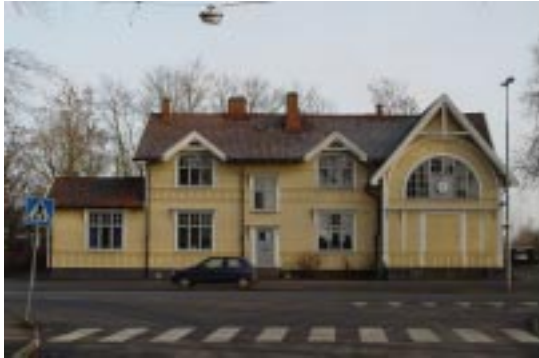
Den gamla järnvägsstationen är en viktig nyckelbyggnad.
