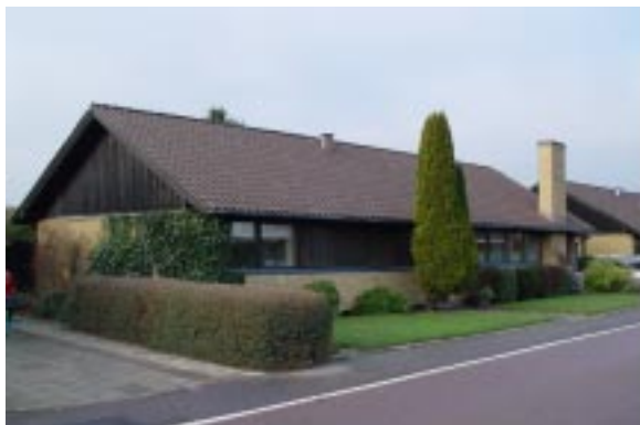
Andresens hus på norra delen av Storkvägen.
