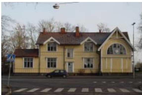
Bjärreds station från väster.
