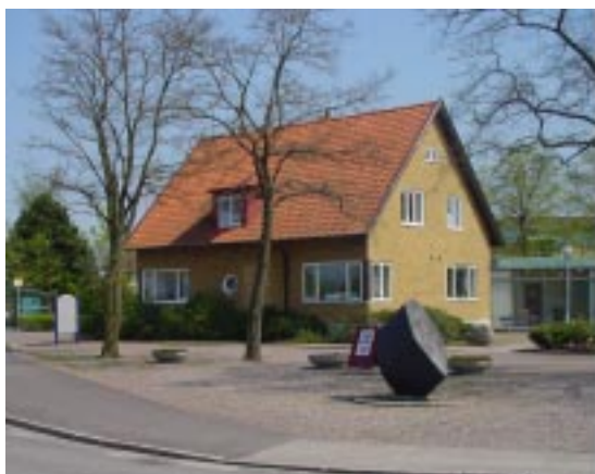
Den norra byggnaden, sedd från norr.
