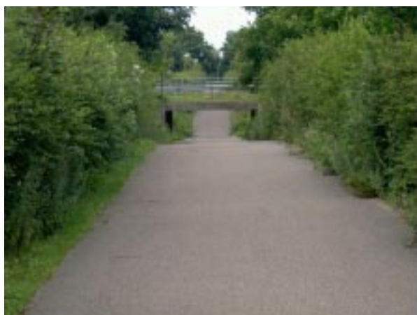
Passage under Mellanvägen.
