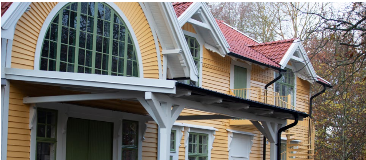
Upprustningen av stationen i Bjärred påbörjades under året.
