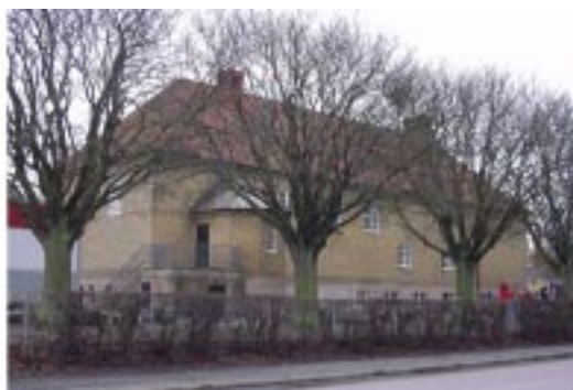
Den västra skolbyggnaden sedd från väster.
