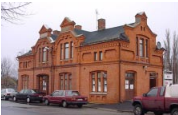
Lomma station är ett exempel på en viktig nyckelbyggnad.
