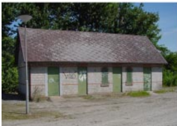
Uthuset från söder.
