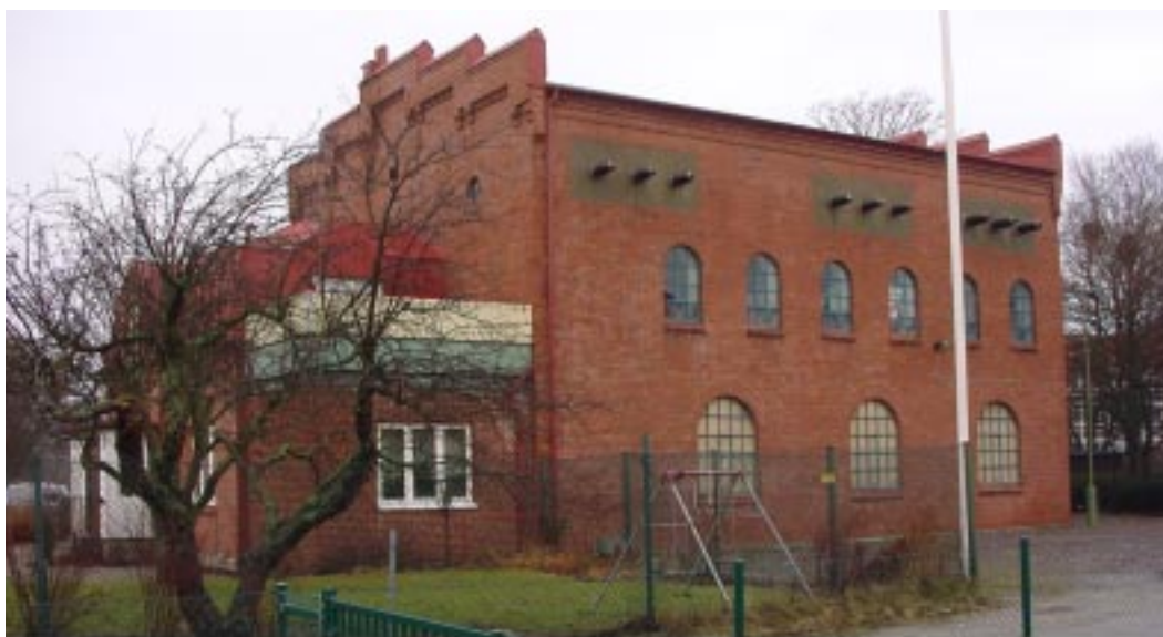
Kraften från söder. Strax under takfoten finns isolatorer bevarade.
