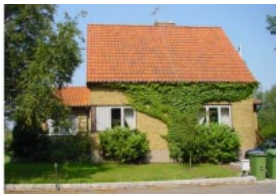
Gult tegel dominerar som fasadmaterial i området.
