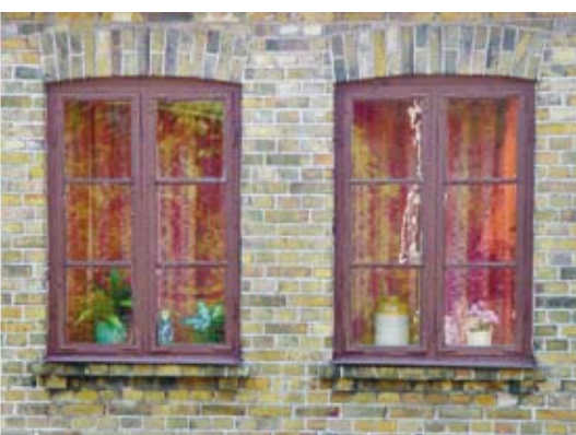
Sexdelade fönster med fasta mittposter och spröjsar. Sidohängda och utåtgående fönster.
