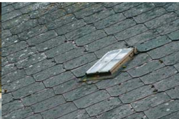
Takfönster i gjutjärn.
