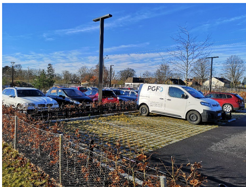
Figur 11: Genomsläpplig beläggning på Lomma station.
