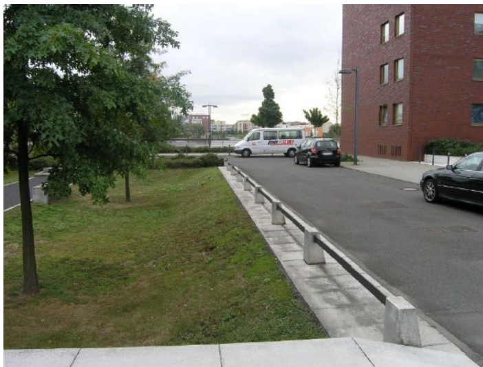
Figur 10: Exempel på en torrdamm i anslutning till en väg. Foto: WRS, 2022
