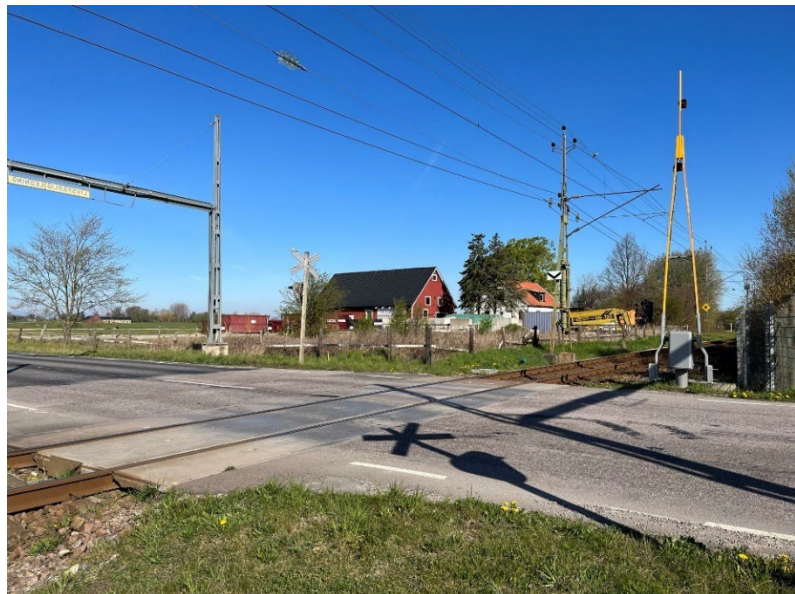
Figur 2: Bild på platsen där Lommabanan korsar väg 913 idag. För att öka trafiksäkerheten bygger Trafikverket om den befintliga plankorsningen om till en planskild korsning likt den som byggdes intill Lomma station på Vinstorpsvägen.
