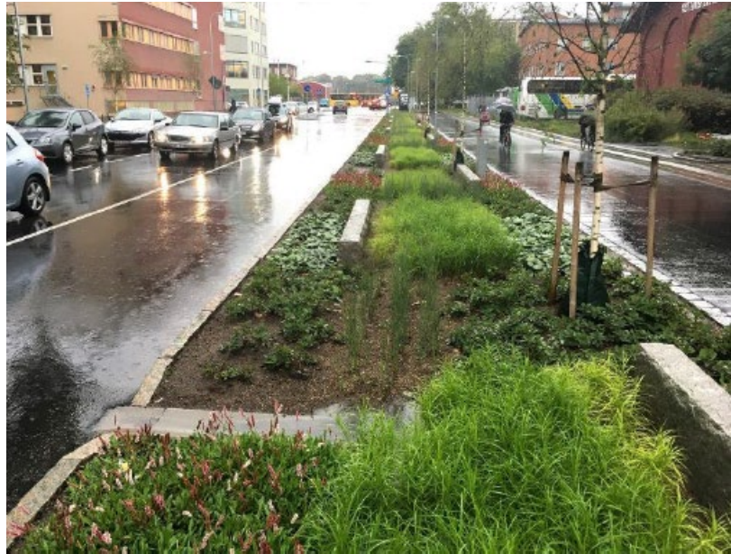
Figur 12: Exempel på nedsänkt växtbädd som omhändertar dagvatten som avrinner från väg och GC-väg. Foto: WRS, 2022
