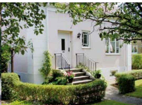
De tidiga husen har källare och höga socklar. Fönstren är sexdelade eller har korsposter med spröjsade överluffer.
