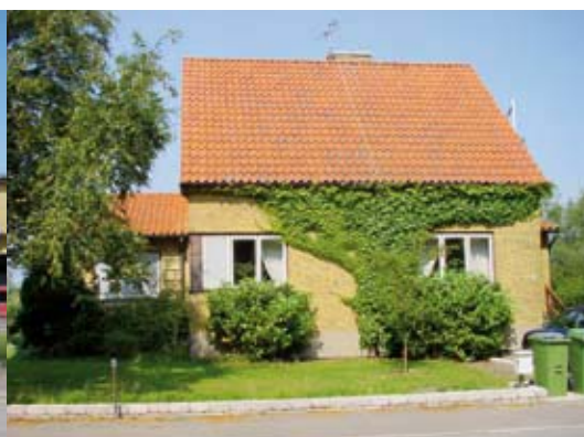
De yngre byggnaderna har ofta oputsade tegelfasader. Fönstren är ospröjsade.
