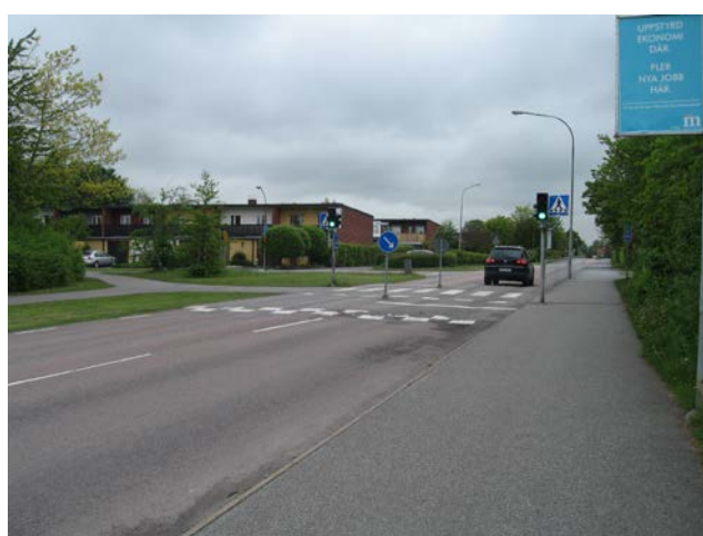
Figur 10-9. Signalreglerad passage i kombination med platågupp. Passagen är över Västanvägen och denna utgör en viktig länk för barn till och från skolan.
