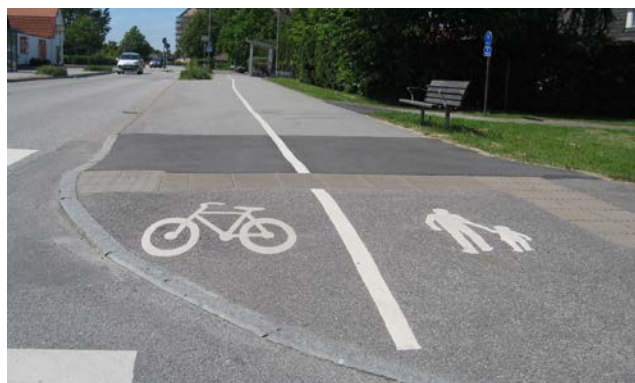
Figur 9-16. Separering med målad mittlinje och målade symboler som illustrerar vilken sida trafikslagen ska använda.
