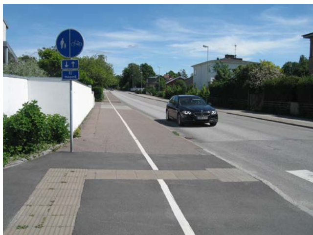
Figur 9-25. Taktila ledningsplattor som sträcker sig ut över cykelbanan. Sinusplattor ska endast används som ledstråk på sträckor om sträckan är säker vilket den inte är vid korsning med cykelbana.
