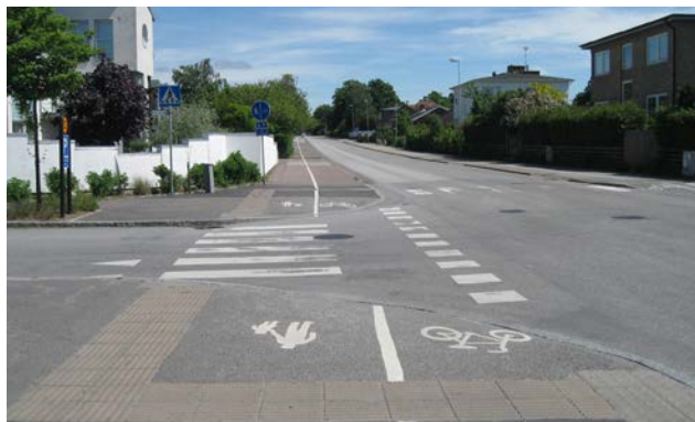
Figur 9-8. Passage över tvärgata till Karstorpsvägen som är utformad med nollnivå för cykeltrafiken och kantsten för gångtrafiken.
