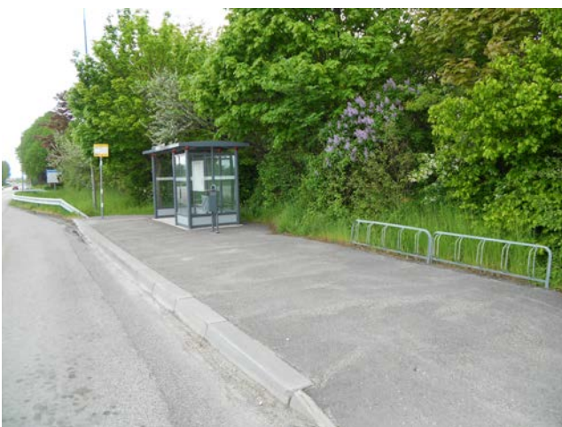
Figur 13-7. Busshållplatsen Fjelie by på norra sidan av Fjelievägen.
