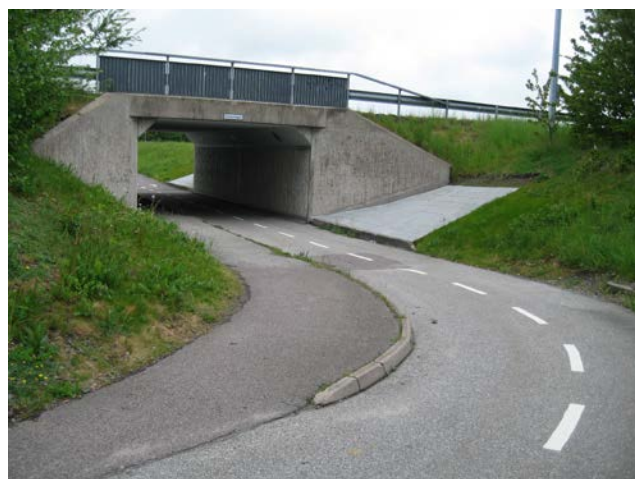
Figur 10-11. Tunnel under Fjelievägen för gång- och cykeltrafik.
