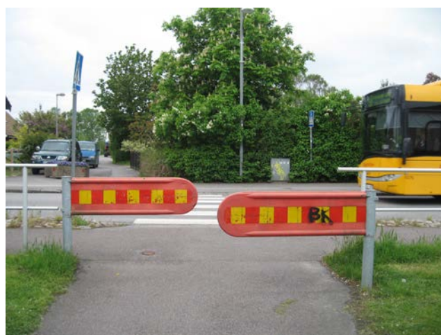
Figur 10-12. Bommar i slutet av cykelväg för att sänka hastigheten för cykeltrafiken innan trafikerad gata.
