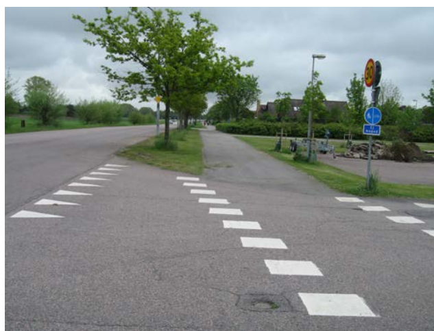
Figur 10-10. Passage över villagata parallell med Västanvägen. Passagen är inte hastighetssäkrad.
