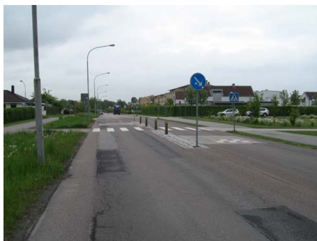
Figur 10-8. Hastighetssänkande passage som är anpassad för busstrafik.
