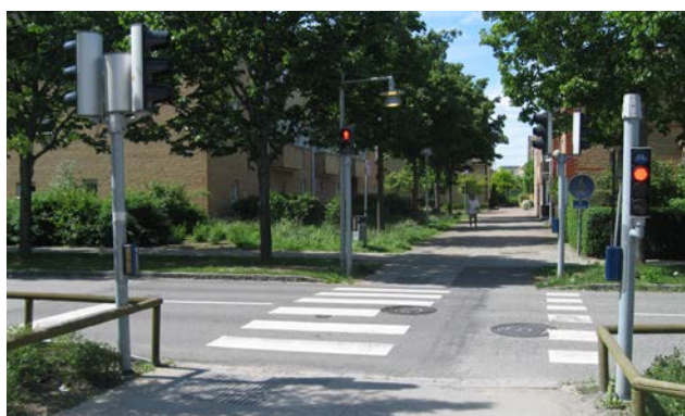
Figur 9-9. Signalreglerad passage över Centrumgatan. Hela passagen är nedsänkt till nollnivå.
