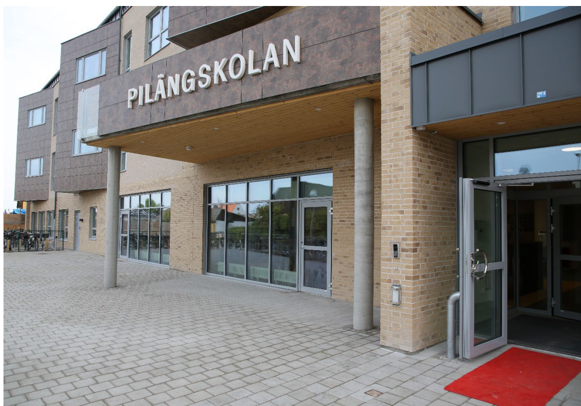
Pilångskolan är under fortsatt ombyggnad. Huvudbyggnaden invigdes augusti 2019.
